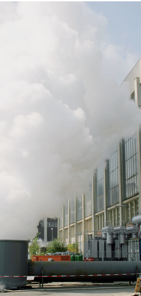
Ausblasen: In Simmering werden die Kesselrohre vor dem Betrieb gesäubert.
